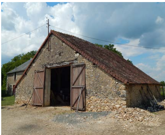
Grange sur poteaux à la Papinerie.
