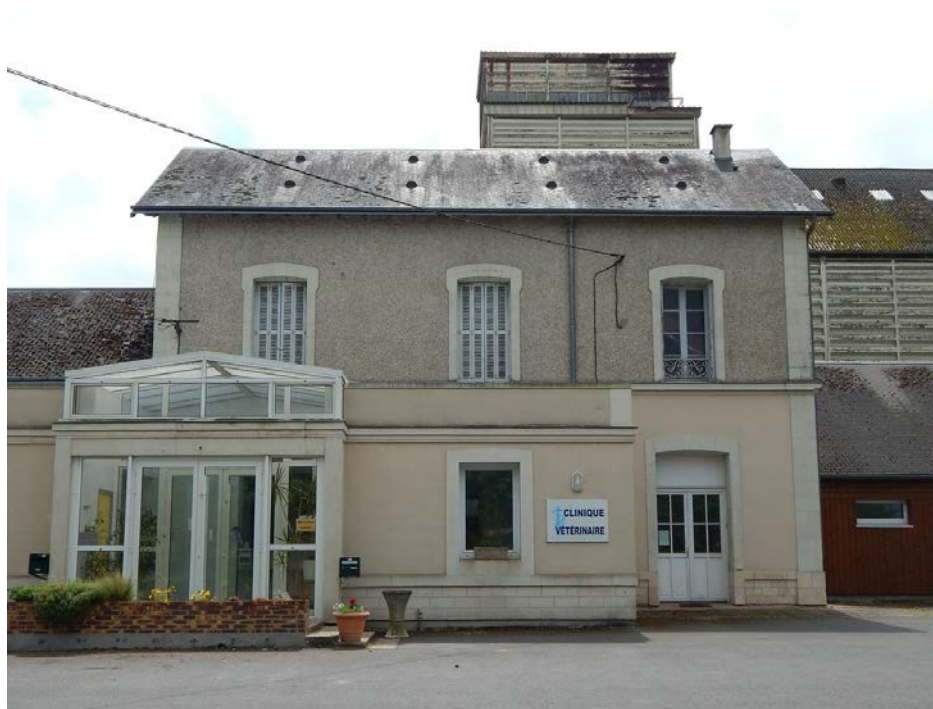
Élévation nord de la gare aujourd'hui.
