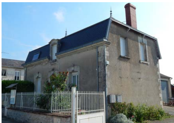
Maison de l'avenue Jourde, ancienne caserne des pompiers.
