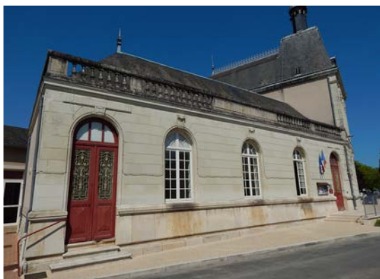
Élévation ouest de l'ancienne salle de justice de paix, accolée à l'hôtel de ville.
