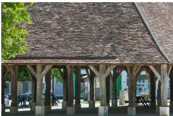
Des blocs de pierre isolent les piliers en bois de l'humidité du sol. © Christian Rome, 2015
