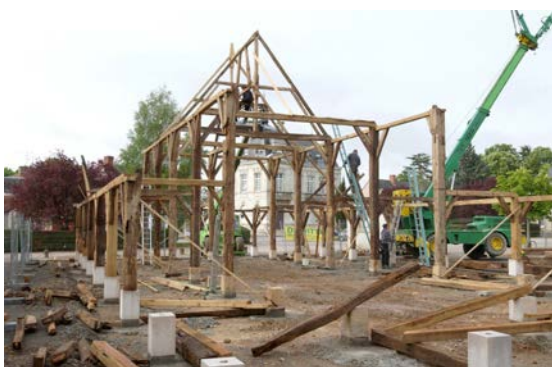
La halle en cours de remontage. © Jacques Besse, 2004
