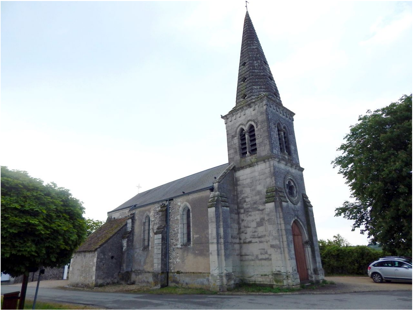
Élévations nord et ouest de l'église Saint-Pierre-ès-Liens de Crémille.
