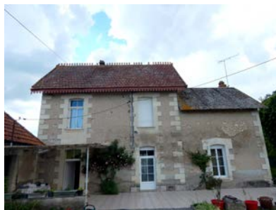
Logement de ferme à la Papinerie.
