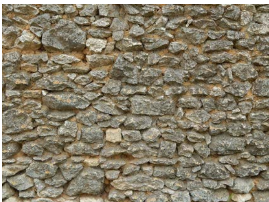
Une maçonnerie de pierre calcaire dure à Russais.
