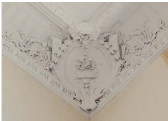
Décor en plâtre du plafond de l'ancienne salle des délibérations.
