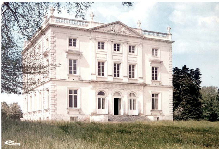
Carte postale montrant les remaniements des années 1930. [élévation nord-est] © Collection particulière
