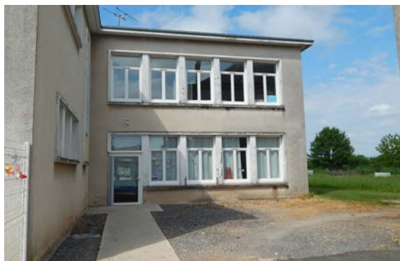
Extension créée par Pierre Gouron pour accueillir une salle de classe en 1957.
