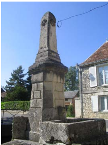
Pompe monumentale du Potet
