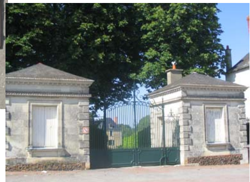
Entrée du château de Pleumartin
